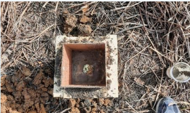
Pemasangan Bench Mark
